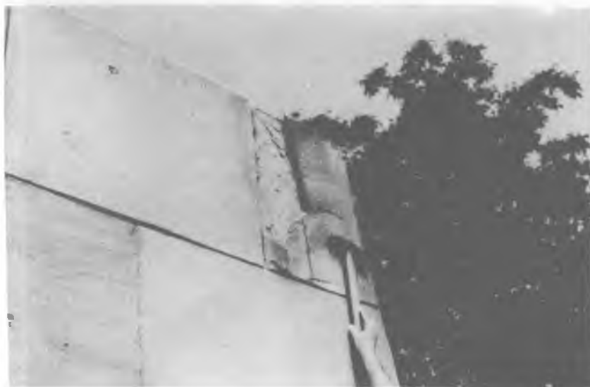
Сл. 4. Плочасто-љуспасто распадање пешчара паралелно слојевитости. Fig. 4. Exfoliation of sandstone parallel to layering.
