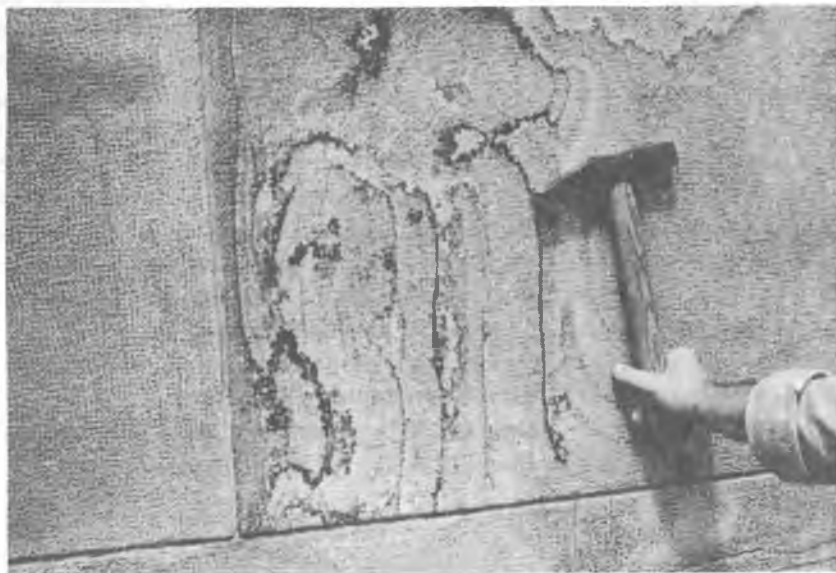
Сл. 1. Сачувани конволутивни облици у уграђеном пешчару. Fig. 1. Relicts of convolution in built sandstone.
