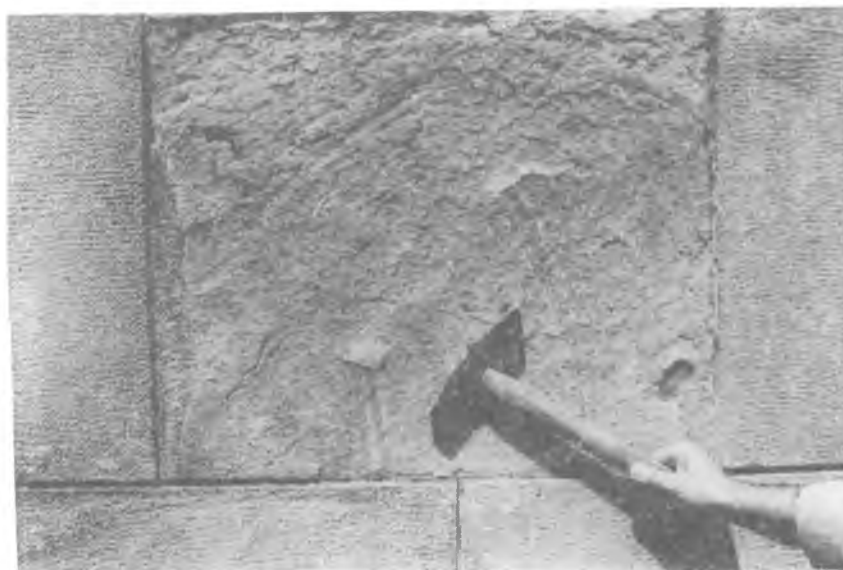
Сл. 6. Љуспасто-зрнасто распадање. Fig. 6. Flaking and granular disaggregation.
